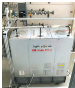
バイオガス発電機
