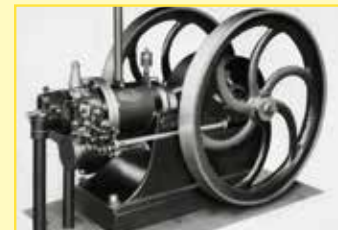
6馬力吸入ガス発動機
